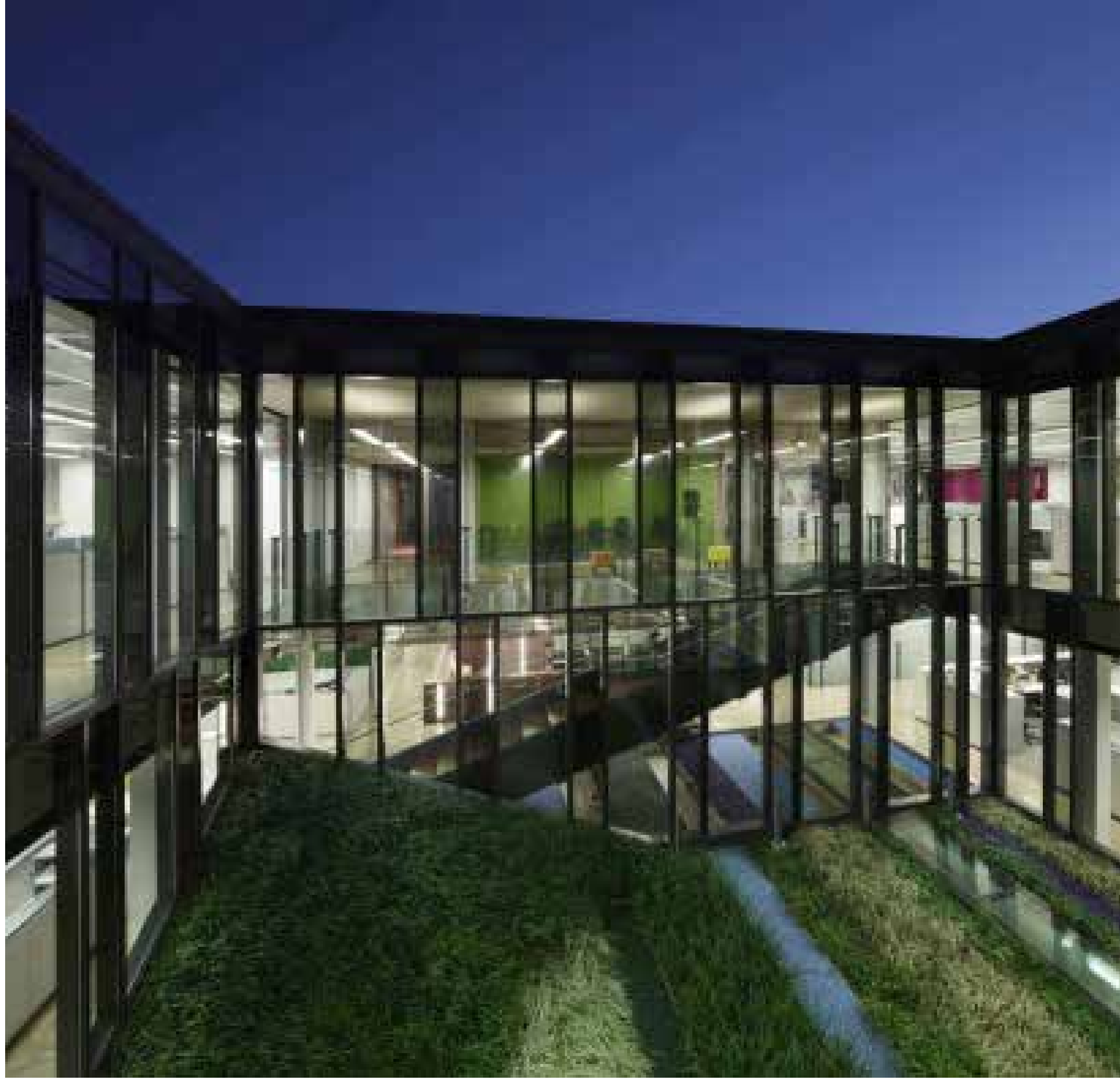
Ankara TOBB Üniversitesi Kampüsü Kentsel Tasarım ve Peyzaj Uygulama Projesi TOBB University Campus Urban Design and Landscape Constructional Project
